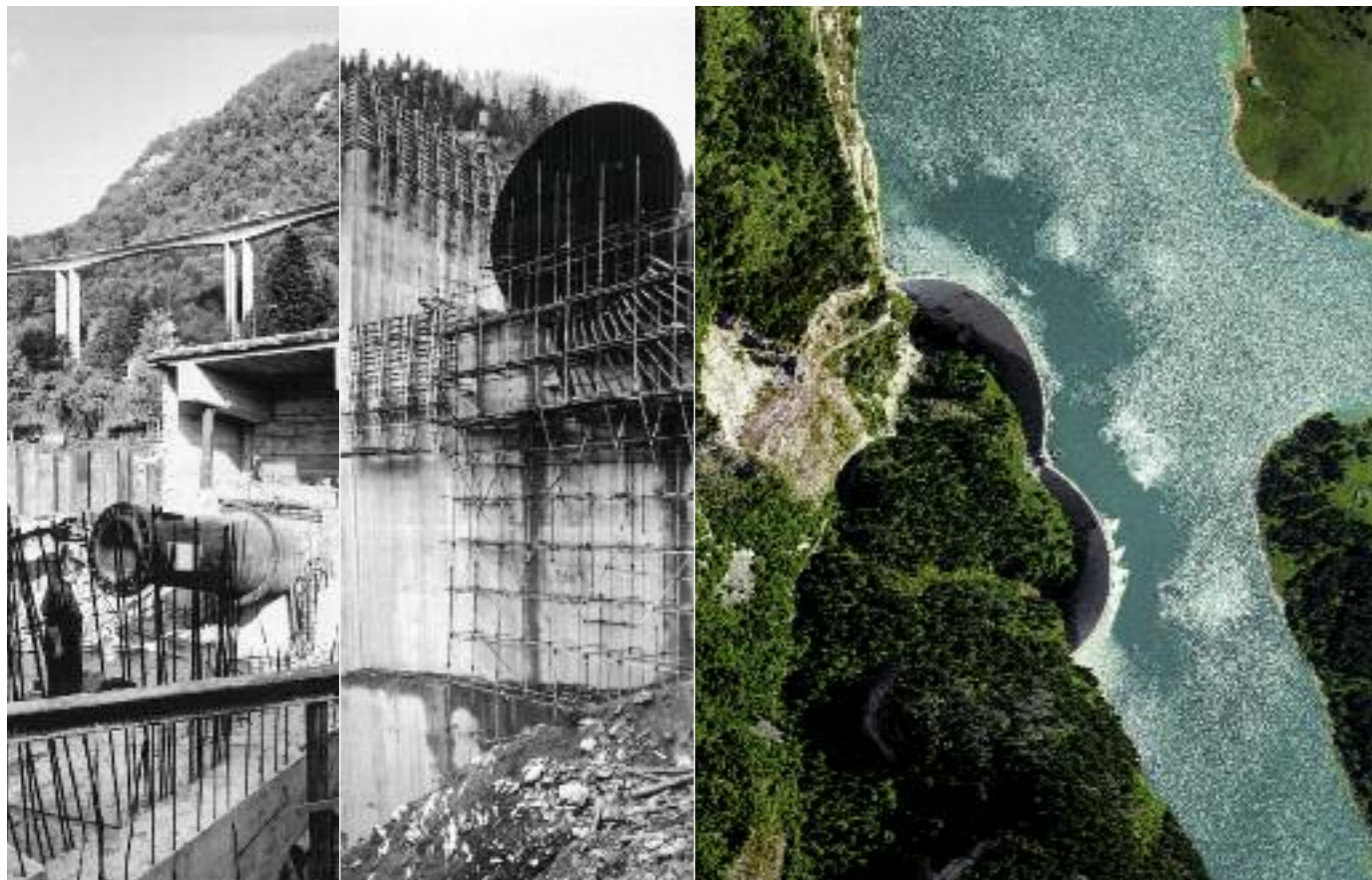
Veytaux: Bau des Kegelstrahlschieber in den siebziger Jahren
