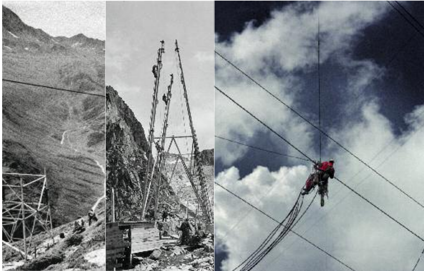
Errichtung eines Strommastes beim Bau der 220 kV Leitung beim Grand St. Bernard-Pass, 1955
